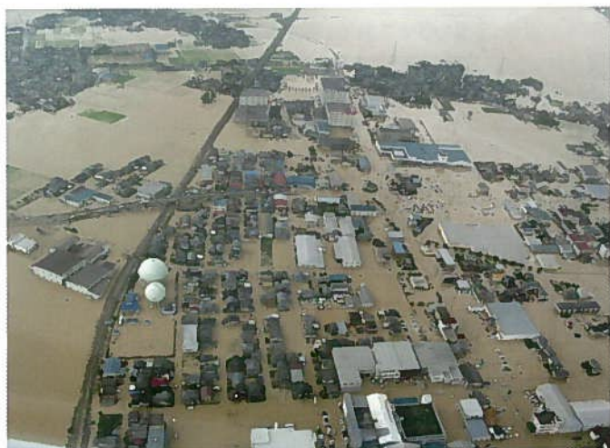
2004年7月新潟・福島豪雨で浸水した三条市
