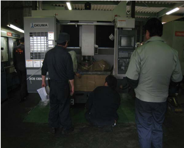
カバーを取り払っての レベル出し・機械設置 作業
